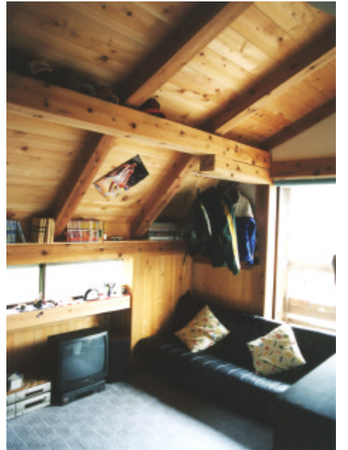
2階子供室 小屋組がそのままインテリア
