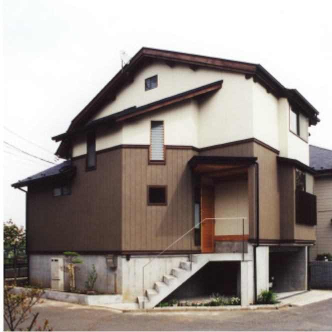
半地下に駐車場を設け、その上に木造架構を載せてる
